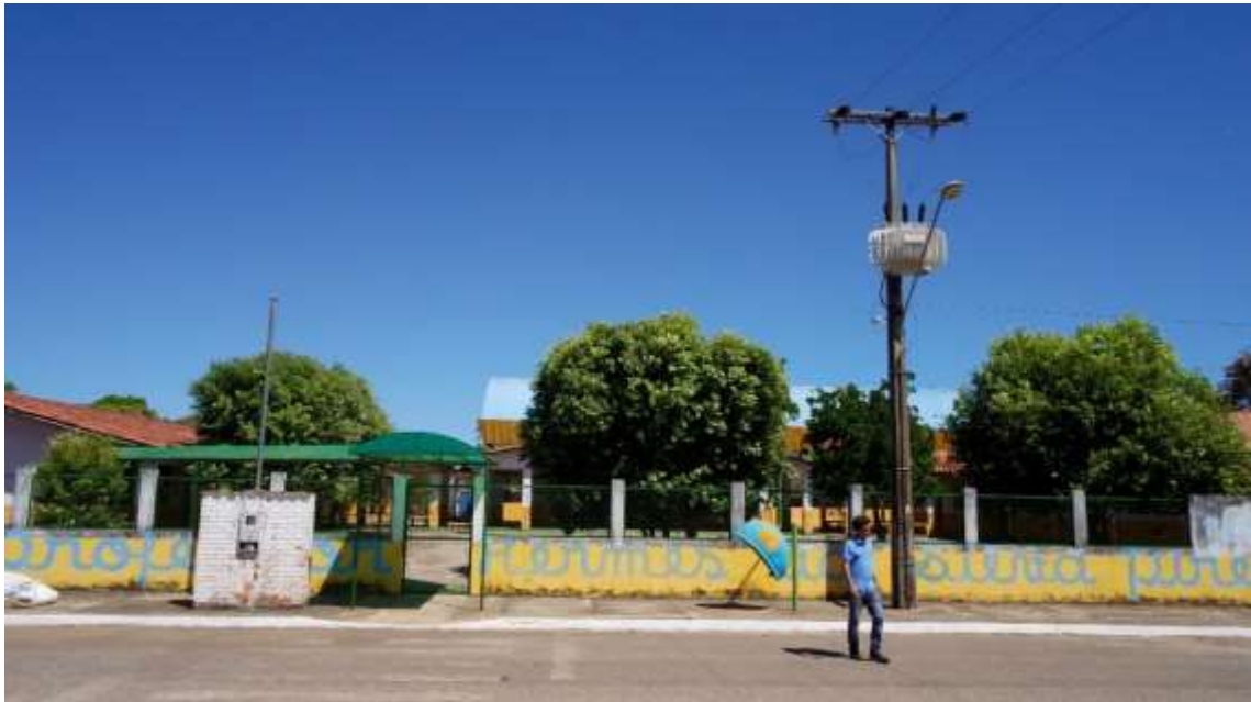
Figura 1 – Vista Geral entrada de energia
